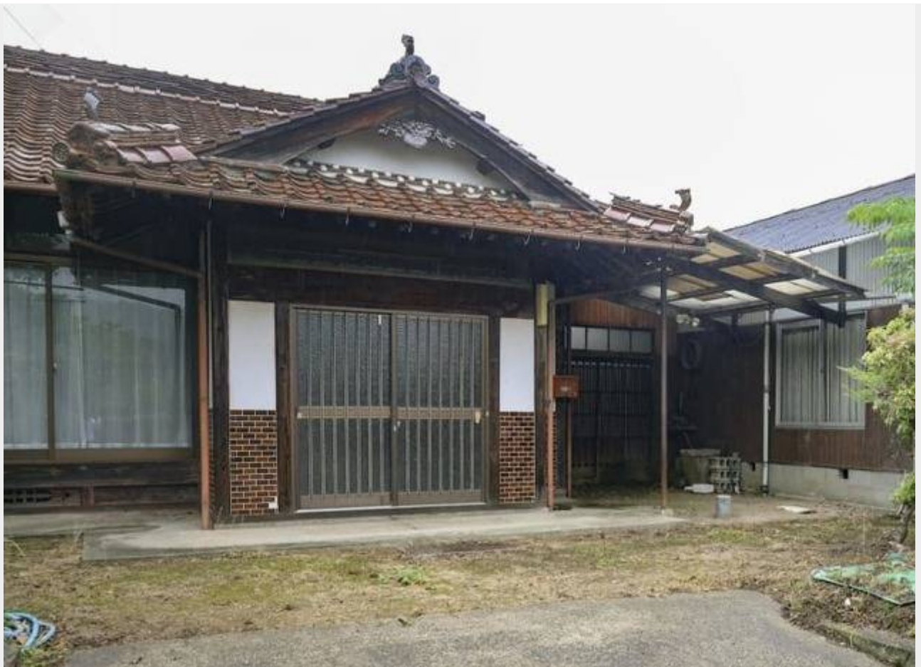
スオン・ティ・ボット被告が住んでいた社員寮 2022年5月、広島県東広島市
